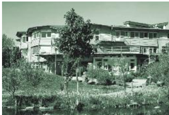
Freie Waldorfschule Köln Architekt: Peter Hübner
